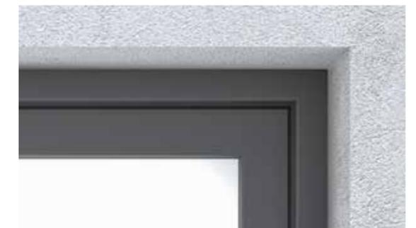
Ein Beispiel für eine konkurrierende Lösung, bei der der Flügel überproportional über die Rahmenkontur hinausragt.
